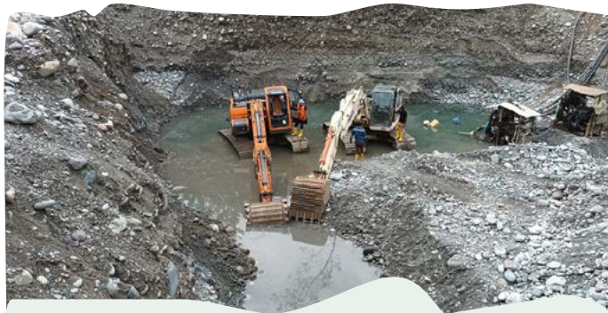
Con máquinas retro excavadoras destruyen el río y la selva
