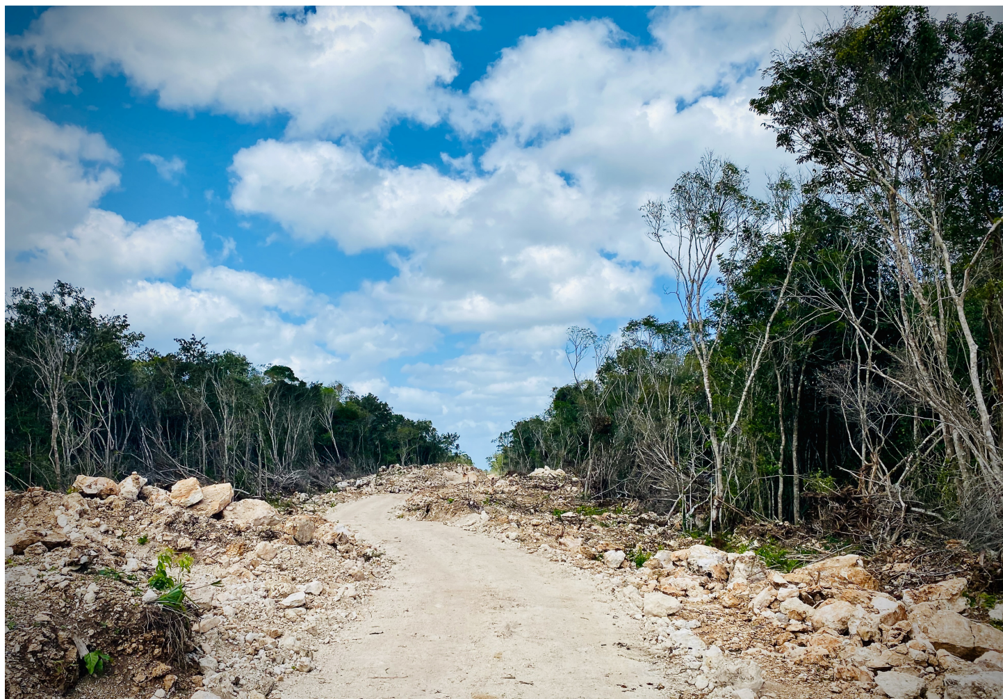
Deforestación para las obras del Tren Maya (Foto: @Sanz-Hess)
